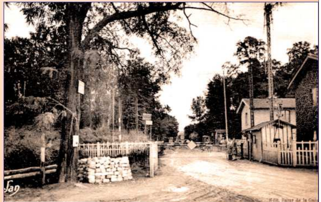
7. Le Vert-Galant (S.-et-O.) — Passage à niveau
